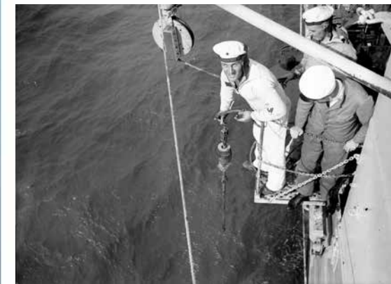
Zur Kontrolle der Echolotmessungen wurden immer wieder Drahtlotungen durchgeführt, letztlich mit dem Ergebnis, dass die Echolot-Technik absolut verlässlich ist.
