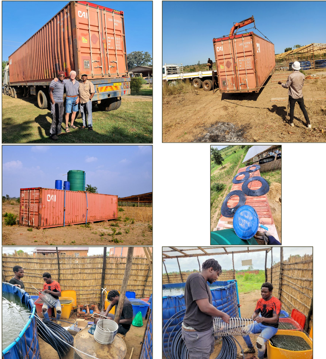
Abb. 8: Ein von der Malawi-Hilfe gespendeter 40-Fuß Container wurde auf dem Grundstück der Pilotfarm aufgestellt und dient dort als Lagerraum und "Wasserturm" um Druck zu erzeugen und als Kollektor für Sonnenwärme (Solarthermie). Die auf dem Dach des Containers verlegten Schlauchschleifen erwärmen das Wasser in den Fischtanks um auch in der Trockenzeit eine Temperatur deutlich über 20°C in den Fischtanks sicherzustellen. Auf dem ersten Bild oben links ist Werner Böttcher zu sehen, der das Projekt am 5. Mai 2023 anlässlich des Containertransports zur Pilotanlage besucht hat. Die beiden unteren Bilder zeigen die Vorbereitung der Metallspiralensysteme, die als Wärmetauscher in die Fischtanks eingelegt werden. Diese Metallspiralensysteme sind mit den Schlauchringen auf dem Container verbunden und bilden ein geschlossenes System in welchem das durch die Sonne erwärmte Wasser zirkuliert und die Wärme an das Wasser im Fischtank abgibt.
