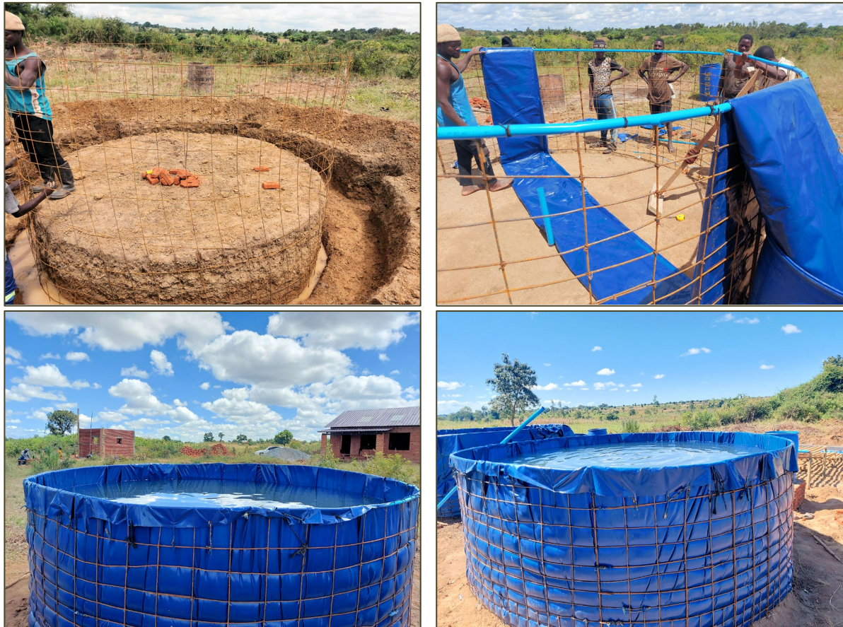
Abb. 6: Konstruktion der Fischtanks. Nach den vorbereitenden Schachtarbeiten für das Fundament wurden die Tanks aus Baustahlmatten und Kunststoffolie errichtet.
